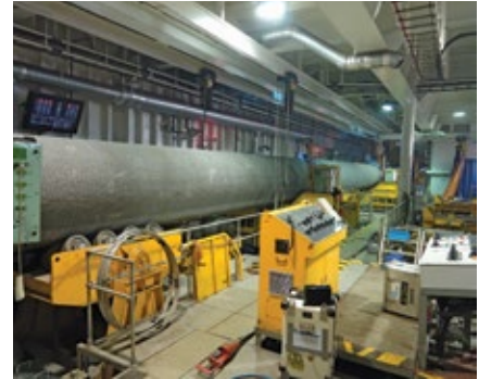
Dit is een overzicht foto van de lasstraat op de Stingray. De rollen bokken onder de pijp voorzien van betonnen mantel zijn voorzien van nieuw leidingwerk. De tensioners die ervoor zorgen dat de pijp gecontroleerd op de zeebodem wordt geplaatst, zijn voorzien van nieuwe manifolds, om de werking te verbeteren. Al het leidingwerk tussen tensioners/bokken/HPU is vervangen ter verbetering van het systeem.
