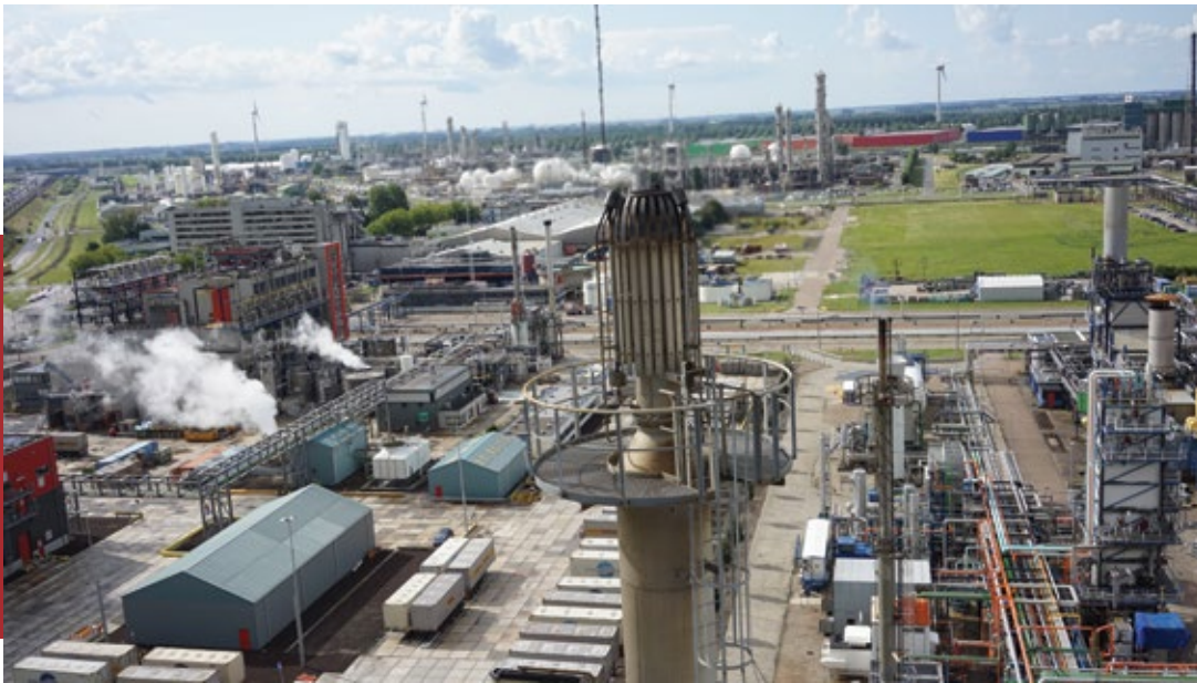
Sky Survey heeft bij een bedrijf in de Botlek de flares geïnspecteerd met een hoge resolutie en infrarood camera.
