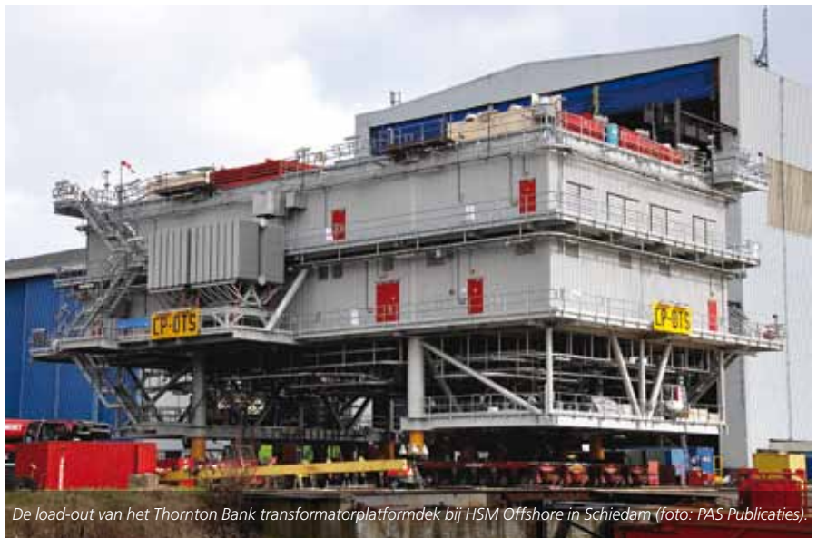
Bij Keppel Verolme is vorig jaar het Global Tech 1 mobiele transformatorplatform gebouwd (Foto: Keppel Verolme).
